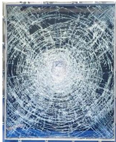
写真1 繰返し圧力载荷試験後の破損状況
